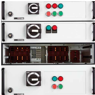
抽屉隔室可满足IP2X的防护要求
