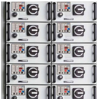
单柜最多可安装28个15kW的1/2抽屉单元
